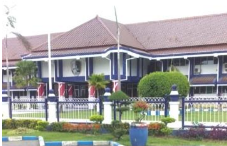
Kantor Pemerintah Kabupaten Sampang
