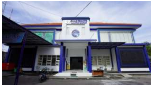
Kantor Diskominfo Kabupaten Sampang
